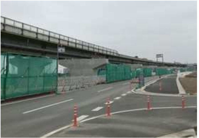
▼圏央道(久喜白岡～大栄)の工事状況
