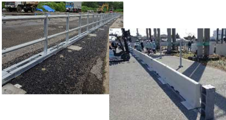
▼公募技術(長大橋・トンネル)の例
