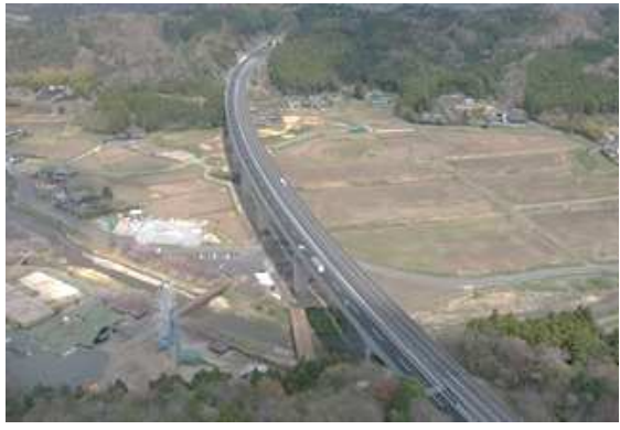
▼常磐道(いわき四倉～広野)の工事状況
