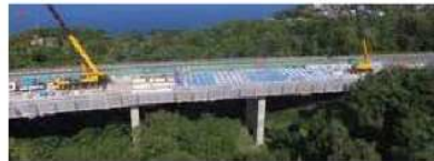
床版取替工事の実例
