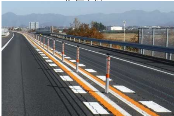
▼ワイヤロープの設置事例
