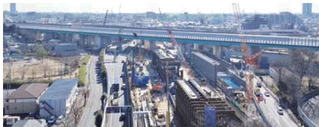
外環道 大泉JCT施工現場
