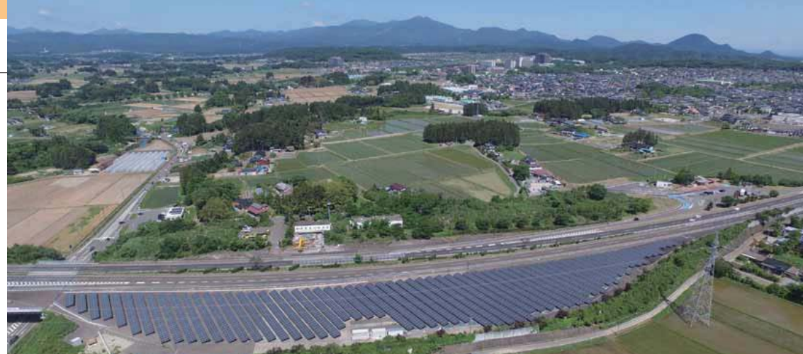
仙台泉太陽光発電所
