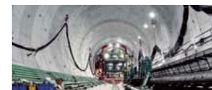
シールド工法による施工状況
