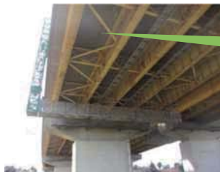
橋梁下面の状況
