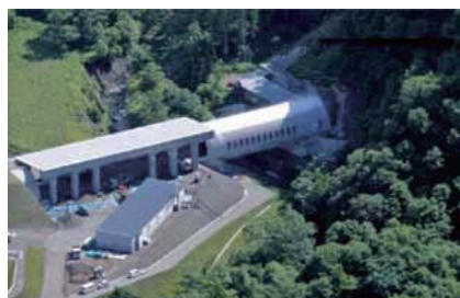
スノーシェルターによる豪雪対策例
