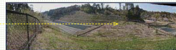
茂原第一トンネル上部全景
