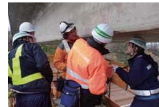
近接目視(打音)による点検
