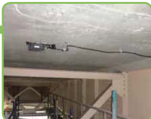
橋梁下面へのセンサの設置状況
