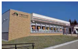
コンビニエンスストア 上信越道 千曲川さかきPA(下り)
