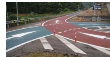
平面Y型ICの平面交差部方向別カラー舗装
