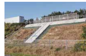
津波避難階段の設置状況 (仙台東部道路)
