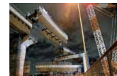
1,250トンクレーン施工状況(高谷JCT)
