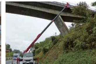
ビームリフター(高所作業車)による点検
