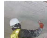
コンクリート片はく落防止対策工事
