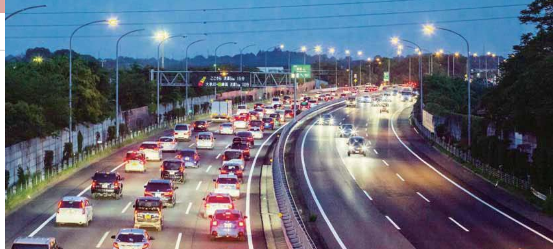
関越道 東松山IC付近
