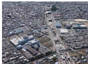
外環道 掘削区間施工現場
