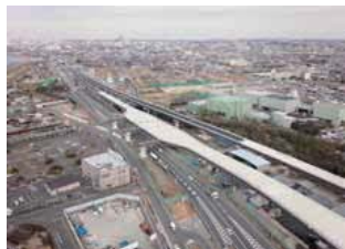
外環道 橋梁区間施工現場
