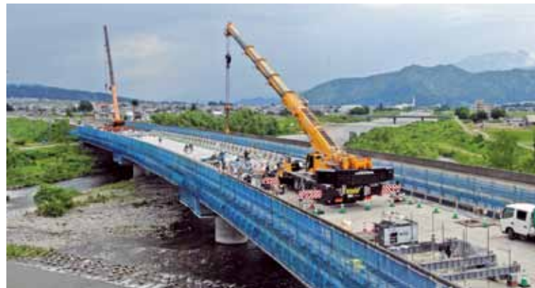
橋梁(床版)リニューアルの様子
