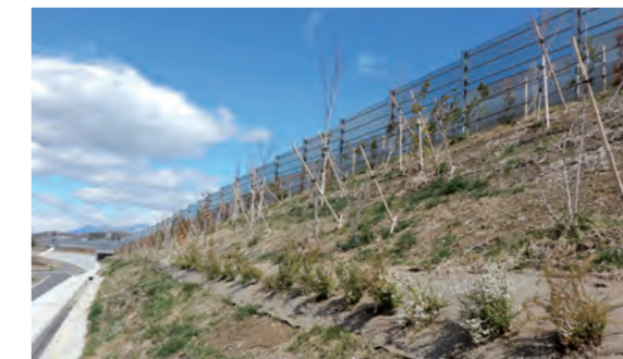
建設時ののり面植栽状況
