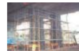
橋脚の耐震補強
