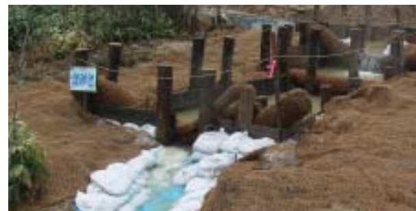
大型沈殿槽を用いた濁水対策の例
