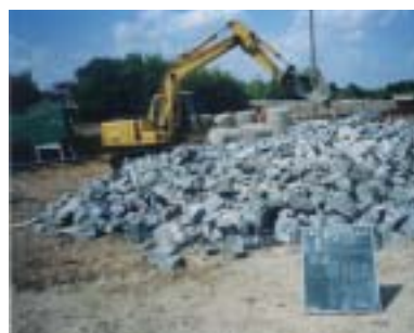
コンクリート塊の再資源化状況（場所打ち杭の小割り）
