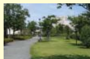
青梅トンネル開削工法区間上部の緑地と換気所(換気所は後方の白い建物)
