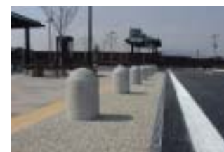
段差のない休憩施設
