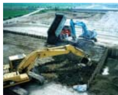
建設発生土の利用の例（場所打ち杭の小割り）
