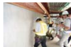
コンクリート構造物における強度確認
