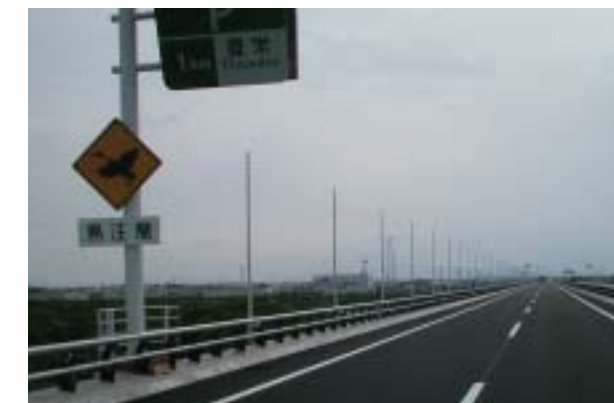
鳥類の衝突防止ポールを設置
