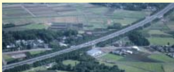
植樹により樹林化した盛土のり面の状況
