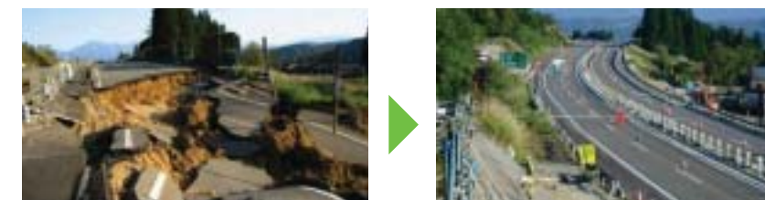
新潟中越地震の震災復旧
