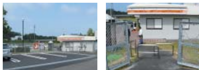
一般道側に設けられた入口(道央道 野幌PA)
