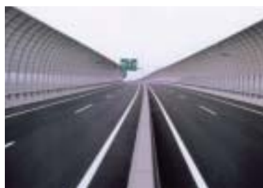
遮音壁の設置事例（外環）
