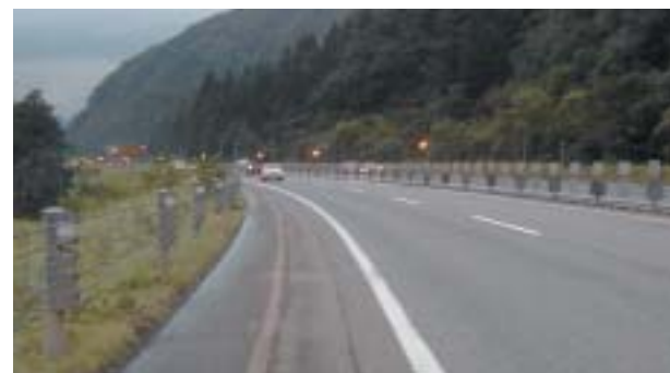
夜間事故対策(自発光デリニエーター)
