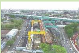
東京外環自動車道(大泉JCT)建設現場
