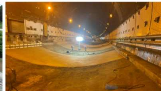
北陸道 米山トンネルインバート設置工事状況
