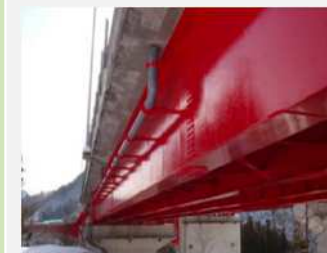
鋼桁塗装（塗替塗装）
