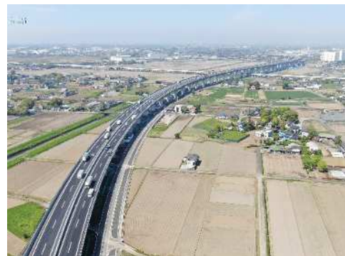
圏央道 4車線化（久喜白岡JCT～幸手IC間）
