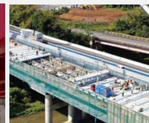
橋梁の床版の修繕
