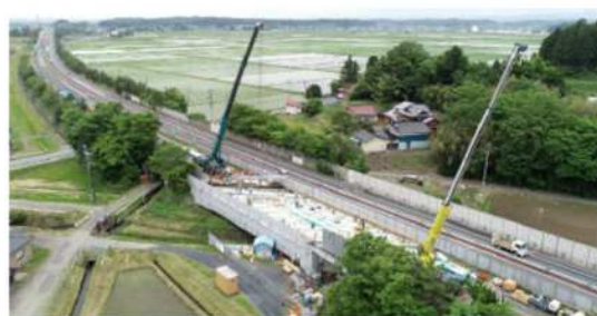
東北道 地田川橋床版取替工事状況
