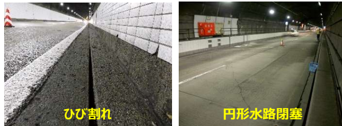
▲盤ぶくれ状況
