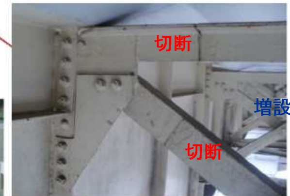
21~25年後 : 対傾構増設と既設対傾構切断
