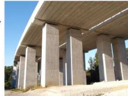
34年後 : 架替後のプレテンPCホロー桁
