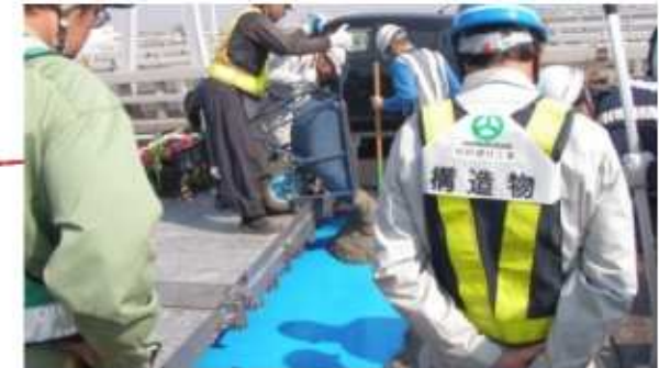
20年後 : SFRC施工(一部)
