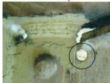
19年後 : ストップホール・折曲げ板取付け
