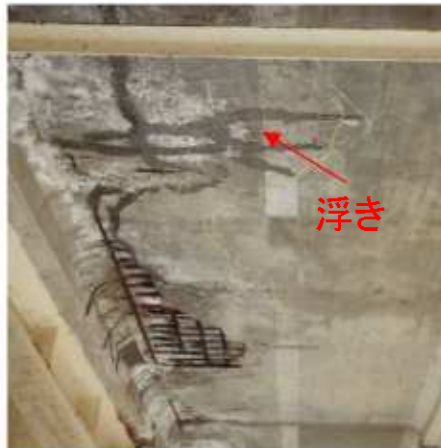
貫通ひび割れを介した橋面水の漏水、遊離石灰、鉄筋腐食、浮き剥離
