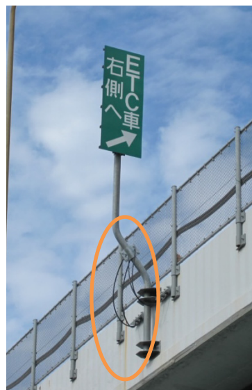
ワイヤロープを用いた落下被害防止構造
