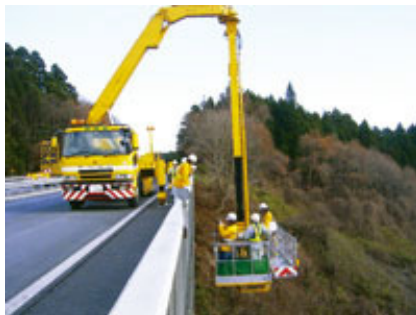
点検困難箇所「橋梁の外観」
