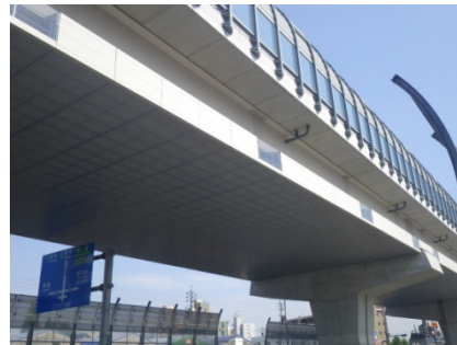
点検困難箇所「橋梁の裏面吸音板」
