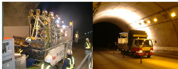
「CCDカメラ」によるトンネル覆工調査の機械化
