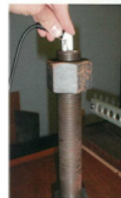
垂直セクタースキャンボルト亀裂検査
