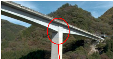
PC箱桁 橋梁内部
