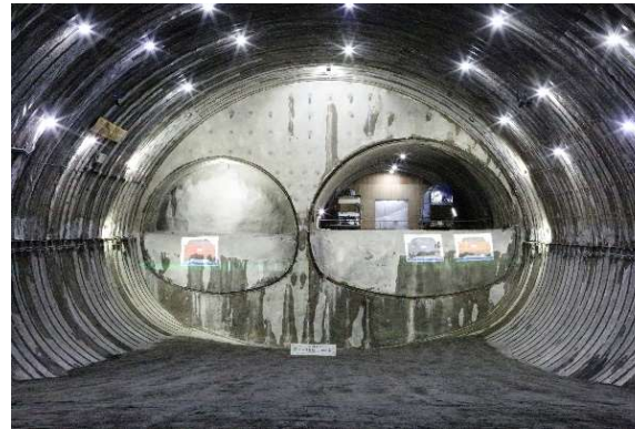
横浜環状南線の工事状況
