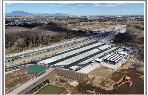
坂東PA(内回り) R6.4.23オープン
