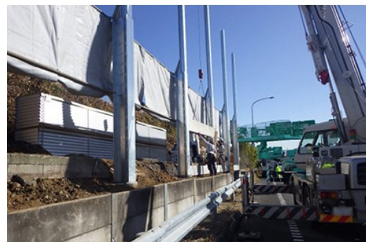
遮音壁工事作業状況
