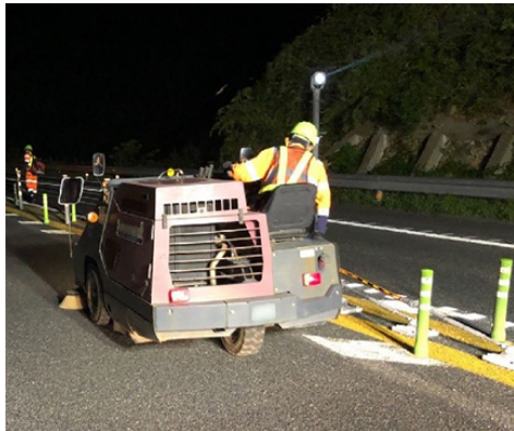
道路保全工事
