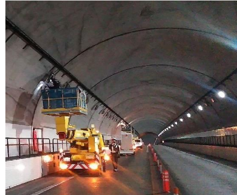
道路構造物点検作業状況
