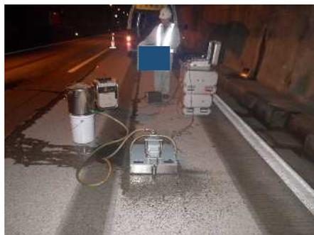
粗面処理工は、コンクリート舗装路面のすべり抵抗性（すべり摩擦係数）を回復する工法。
