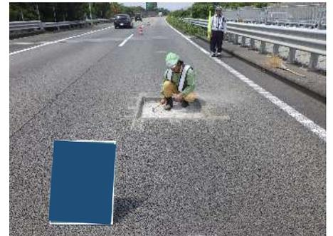
既設舗装の各層の厚さ、ひび割れ状況、層間のはく離状況等を確認。
