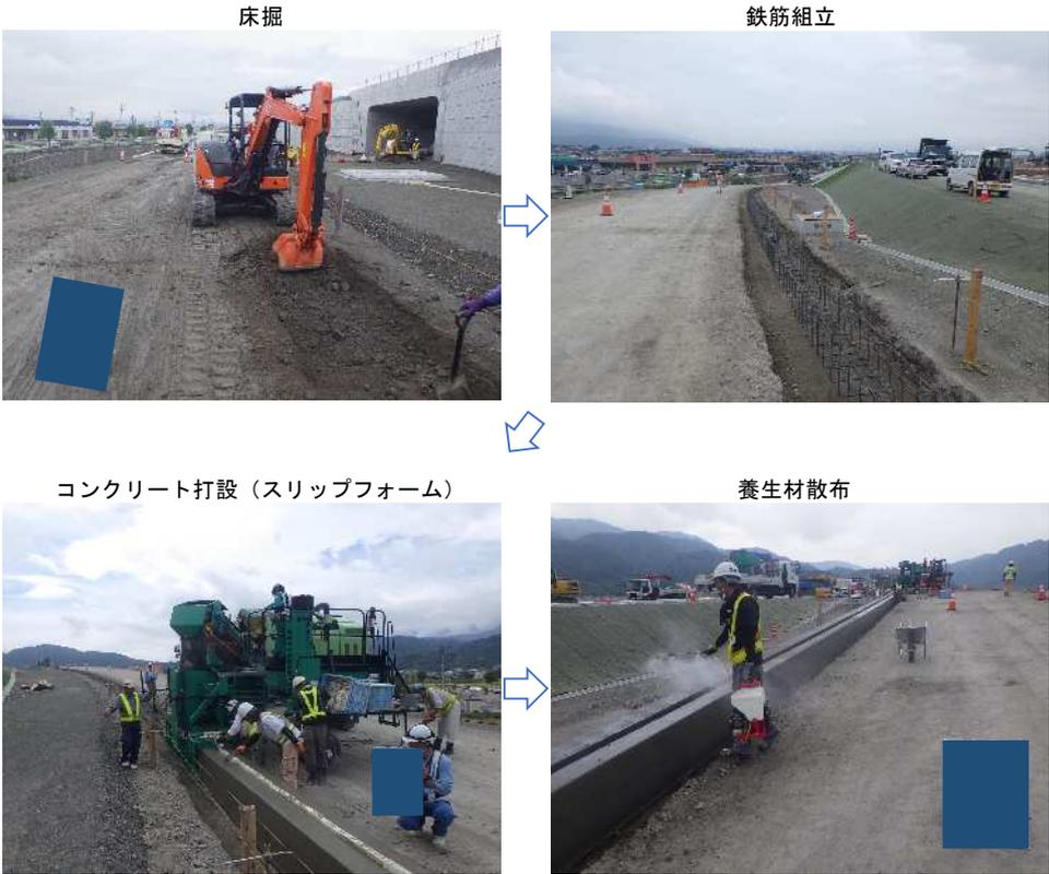
成型機は、コンクリートを供給する搬送装置、鋼製型枠及び締め装置から構成される。
