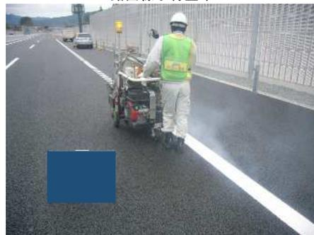
写真は路面標示工標準型の溶融型（手動式）
