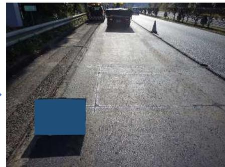
一部の施設設備（計測機器）については、舗装内に埋設されている為、舗装補修を実施する際には必ず、施設設備の有無を確認する必要がある。
