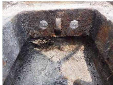
アスファルト表層を密粒から高機能 I 型に変更する場合に、既設橋梁排水ます側面に排水用の孔を開けるもの。
