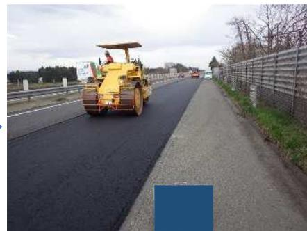
切削オーバーレイ工は、既設アスファルト混合物を切削機により剥ぎ取った後に、アスファルト混合物で舗装路面の性能を回復する工法。
