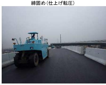
基層は土工部アスファルト舗装の場合、中間層はコンポジット舗装の場合、橋梁レベリング層は橋梁部の場合に表層の下層に施工。
