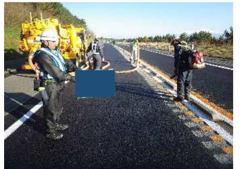
突起型路面標示は除雪作業により早期に消失する恐れがあることから、そのような地域においては凹型注意喚起舗装工等の方法を検討する。
