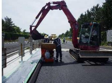
橋梁地覆部に埋設物（電線・通信線等）がある場合は、縁石撤去にあたり事前に探査等で埋設物の位置を確認する必要がある。
