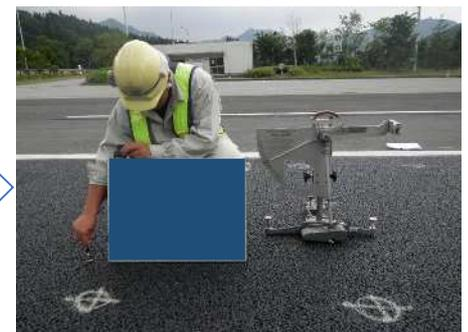
本施工に先駆け、本施工に使用する機械と人員構成で、試験舗装を実施し、各種施工条件を決定するもの。
