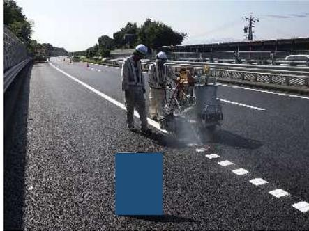
突起型路面標示の施工は、路面標示（ライン）の材料種別により、リップとラインを別々に施工する場合と一体で同時に施工する場合がある。
