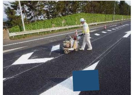
外側線・中央破線の施工は、使用する材料種別によって、車載式及び手動式での施工方法がある。
