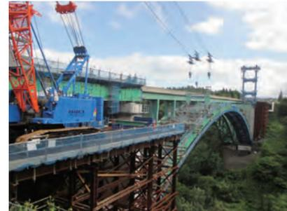
ケーブルエレクション工法による施工状況
