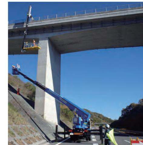
交通規制を伴う高所作業車による点検
