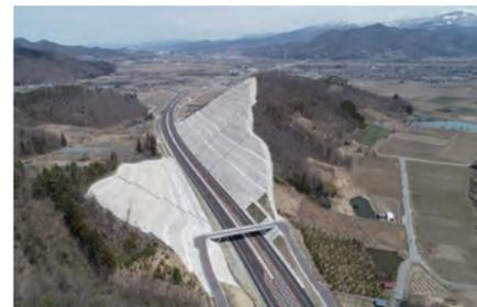
長大切土のり面(12段)の施工状況
