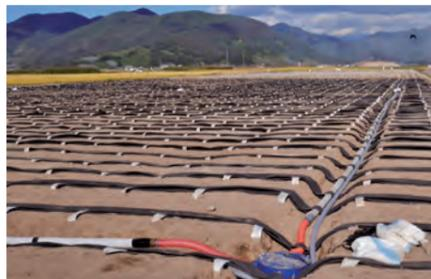
真空圧密工法の施工状況
