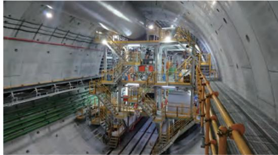
シールド工法による施工状況
