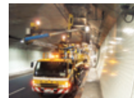
トンネル設備保守作業
