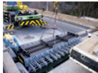
伸縮装置の取り替え
