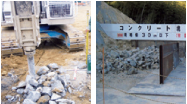
コンクリート塊の再資源化（小割作業）
