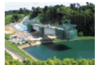
圏央道 東金IC・JCT～茂原長南IC間
