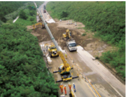
応急復旧作業の状況
