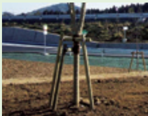
樹木の支柱(圏央道)
