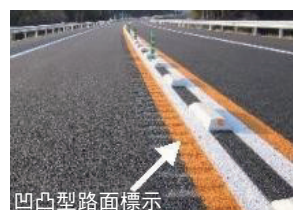
凹凸型路面標示 暫定2車線区間の車線逸脱防止対策(凹凸型路面標示)
