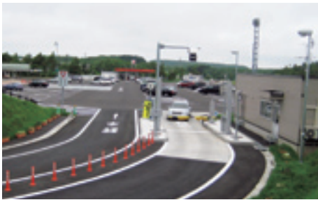
SA・PAに設置されたスマートインターチェンジ
