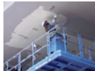
コンクリート片はく落防止対策
