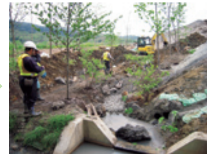
沢の復元工事中
