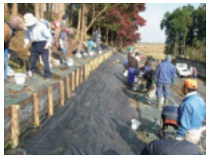
地域と連携した盛土のり面管理（東北道 三本木地区）
