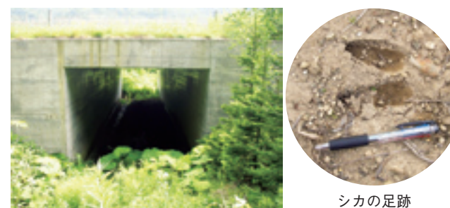
野生動物用横断Boxの設置 （けもの道の確保）
