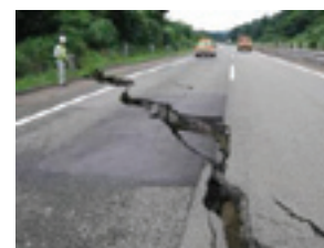
新潟県中越沖地震の震災復旧
