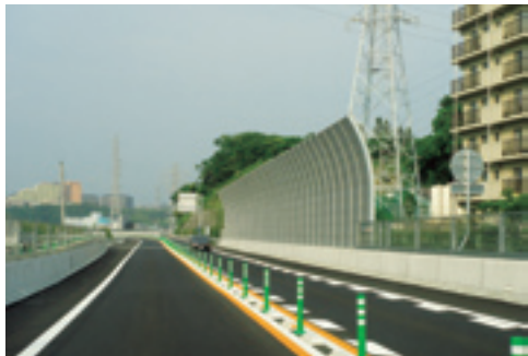
遮音壁の設置(横浜横須賀道路)
