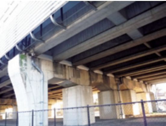
橋梁設置状況
