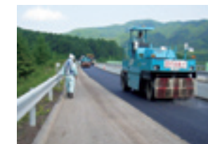
舗装の打ち替え
