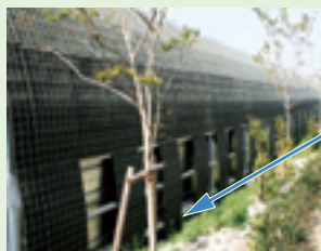
遮音壁裏面の緑化(横浜横須賀道路)
