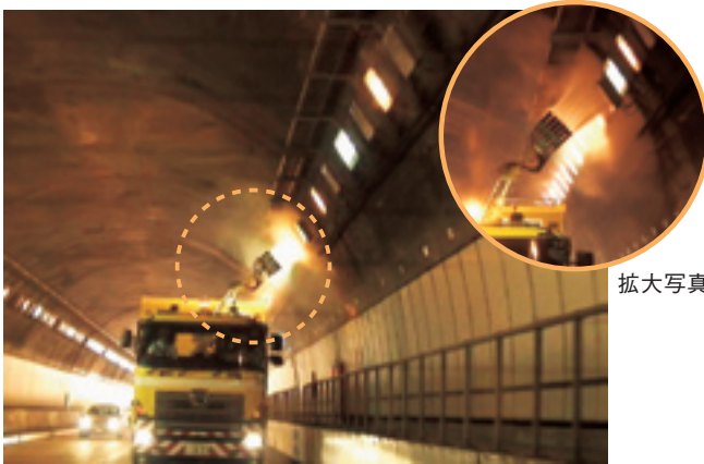
実用中の高速清掃作業の状況
