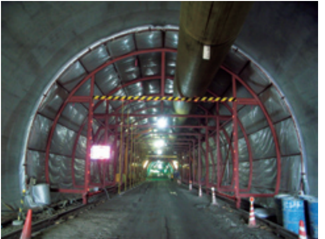
入札前の技術提案(コンクリートの養生方法)を採用した工事
