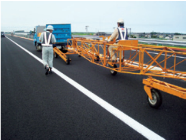
舗装路面の平坦性確認試験
