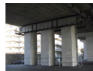
橋脚の耐震補強(施工後)
