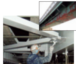
橋梁の塗り替え塗装
