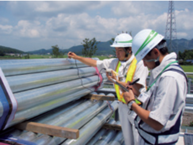
資材を直接調達(支給前の検査状況)
