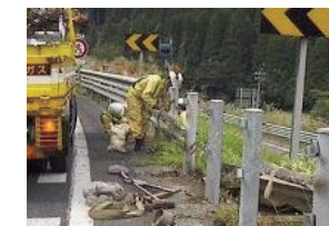
ガードレール取り替え
