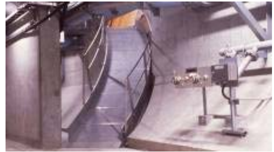
避難経路は車が一台走行できる幅があり、300メートルごとにスロープと非常電話を設置しています
