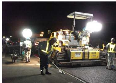
夜間舗装補修工事 作業状況
