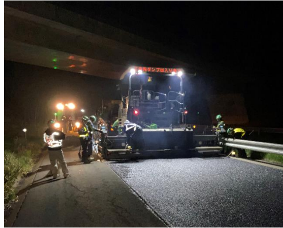
路面補修工事例
