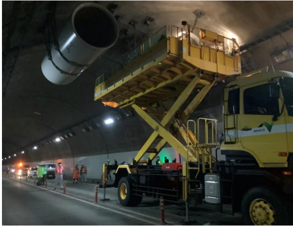
トンネル点検例
