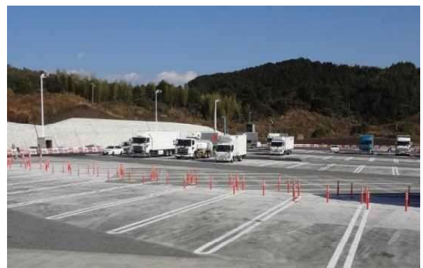
写真-4 大型車駐車場の拡幅状況
