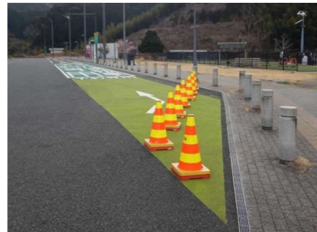
写真-13 カラー舗装による不正駐車対策 (E1A 新東名 静岡 SA(下り))
