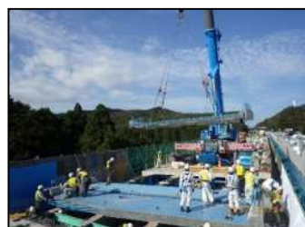
【新しい床版設置状況】
