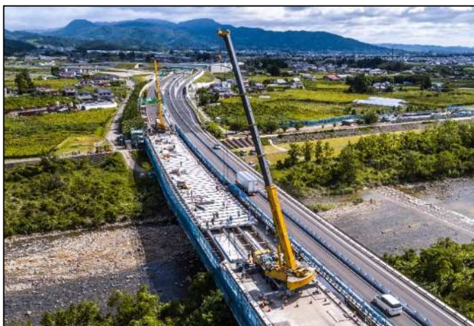
【対面通行規制状況】
