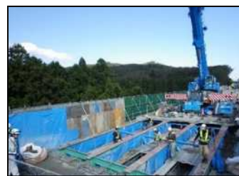
【古い床版撤去状況】
