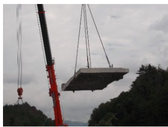
既設コンクリート床版の撤去
