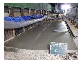
コンクリート打設完了
