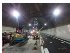
土留杭打設状況
