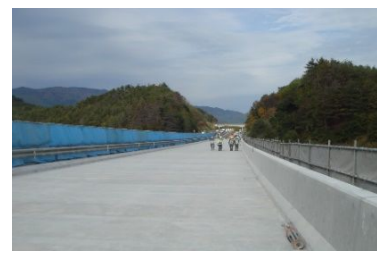
新設コンクリート床版施工完了
