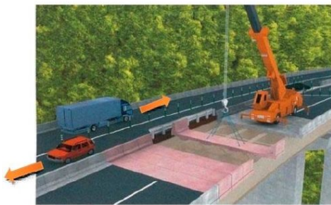
終日対面通行規制時の床版取替工事
