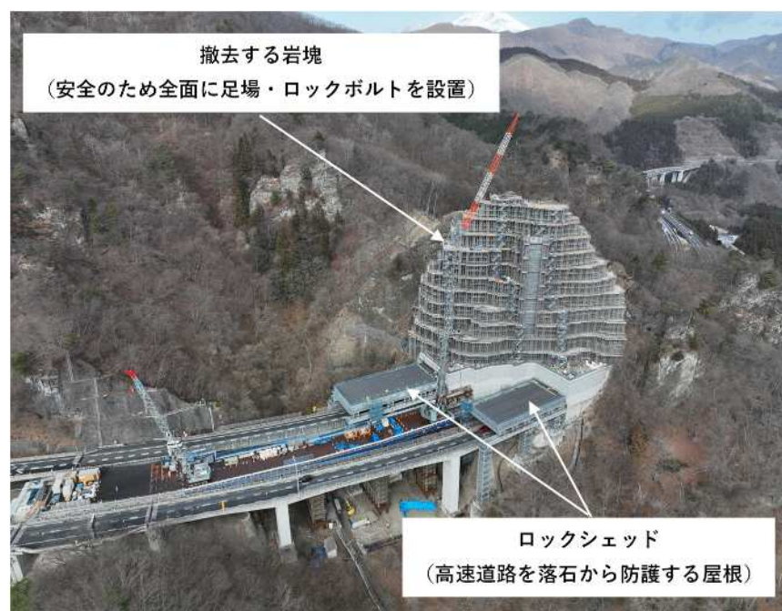
長野側からの施工状況
