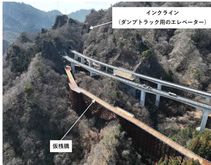
高崎側からの施工状況
