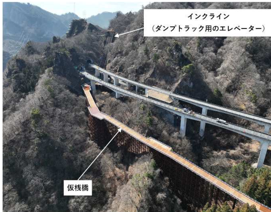
高崎側からの施工状況
