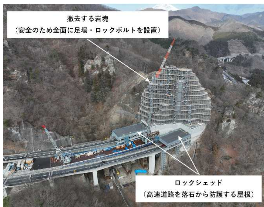
長野側からの施工状況
