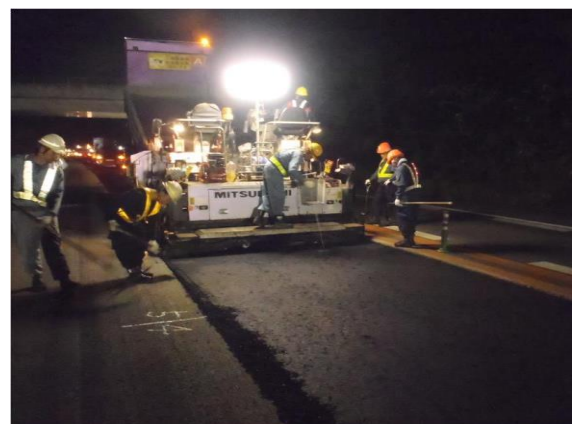
舗装補修工事
