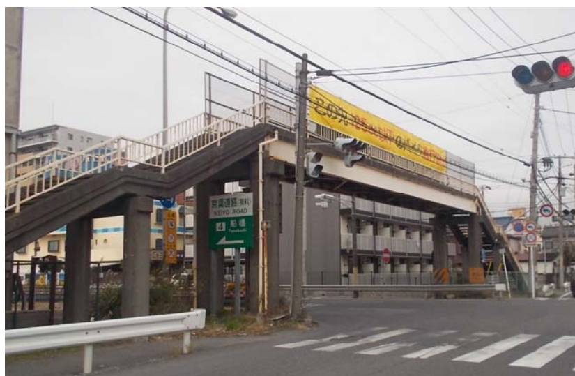
撤去を行う横断歩道橋(海神人道橋)
