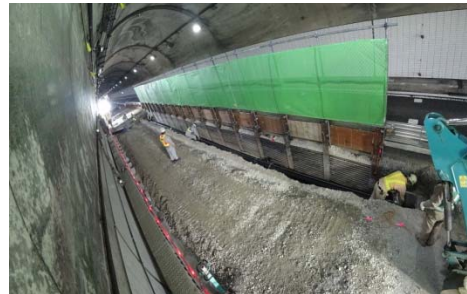
④ 埋戻し～仮舗装～規制解除
