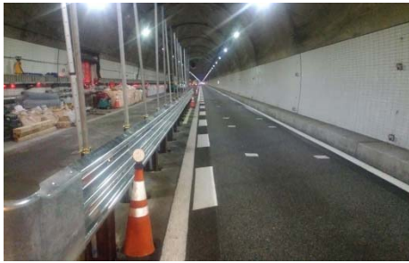
① 車線規制～仮設防護柵設置
