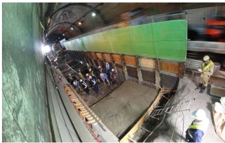
② 掘削～型枠～コンクリート打設
