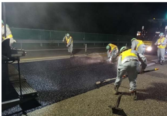
(供用車線の舗装補修)
