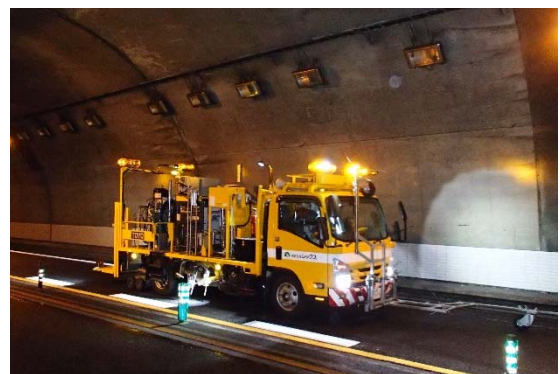
(供用車線の路面標示施工)
