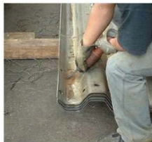
ガードレールサビ取り
