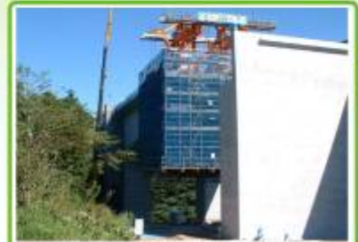
いわきJCT～いわき三和IC 橋梁工事
