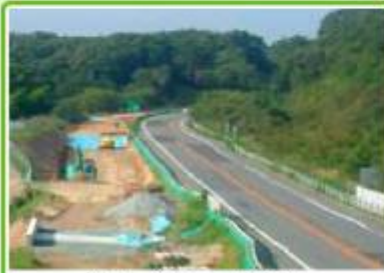
船引三春IC～郡山東IC 土工工事
