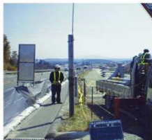
既存ガードレール取り外し
