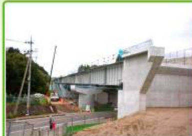
差塩PA～小野IC 橋梁工事
