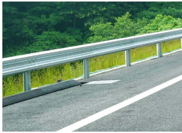
再利用ガードレール設置状況
