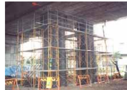
《橋脚の耐震補強》
