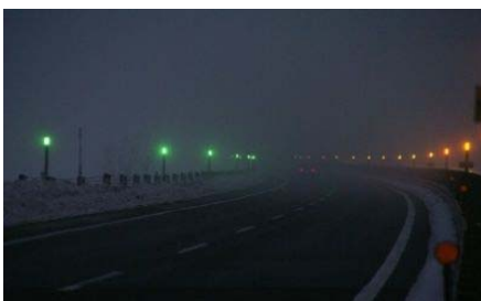
自発光スノーポール (深川IC～旭川鷹栖IC間)
