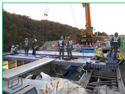
【新設コンクリート床版の設置】
