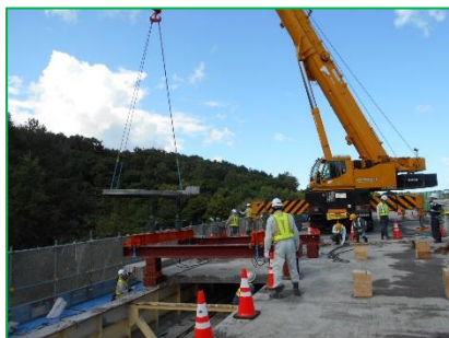
【コンクリート床版の撤去】
