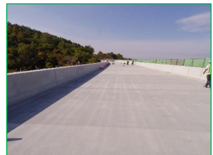
【新設コンクリート床版施工完了】
