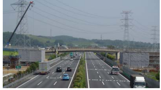
[写真位置②]工事箇所の最新状況 (跨高速道路橋上から新潟方面を望む)
