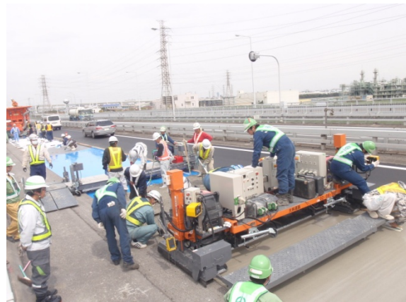
SFRC 打設状況
