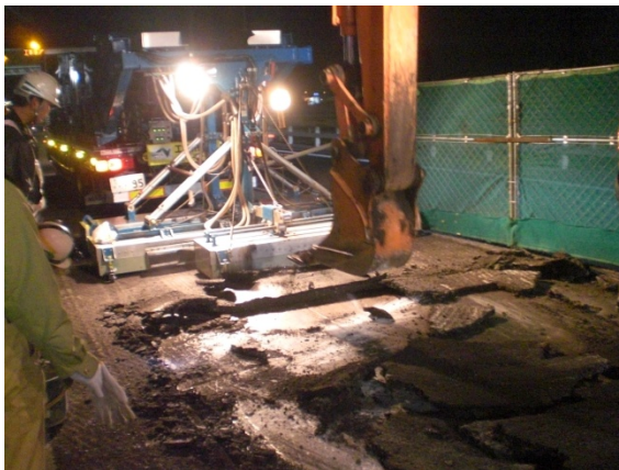
舗装剥ぎ取り状況
