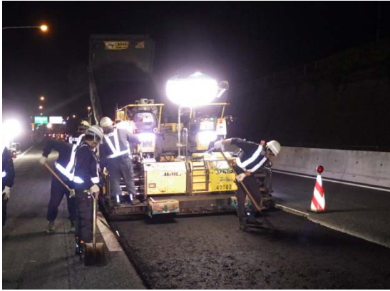
路面補修工事
