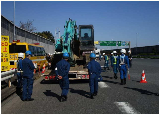
④【首都高速道路(株)/東京運輸支局】大井本線料金所 ＜道路運送車両法と道路法による合同取締風景＞
