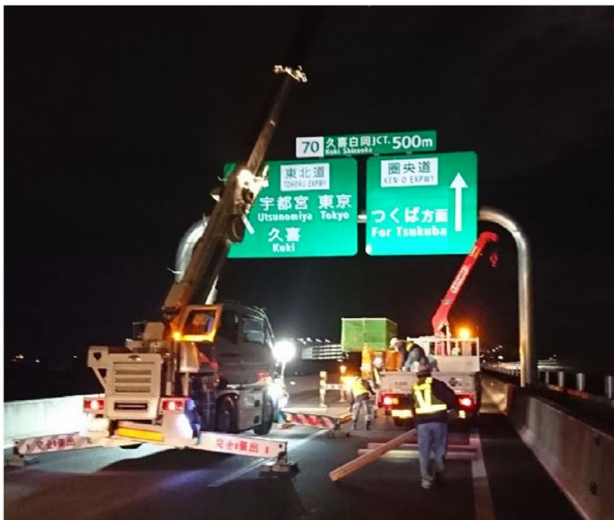
標識設置工事イメージ
