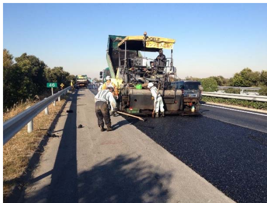
舗装補修工事状況写真
