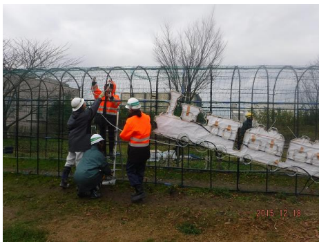
設営中の様子
