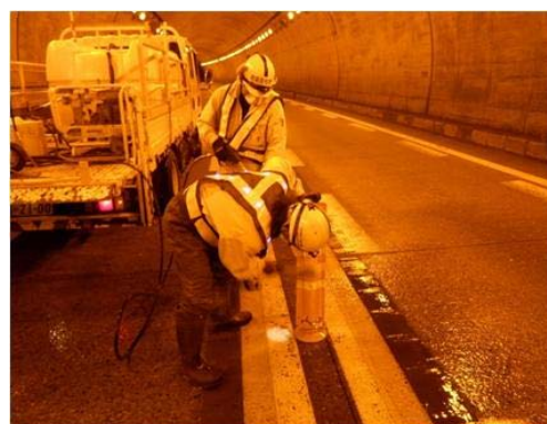
車線分離標の清掃
