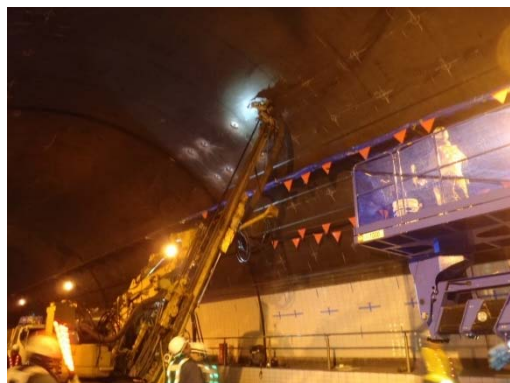
トンネル補強工事
