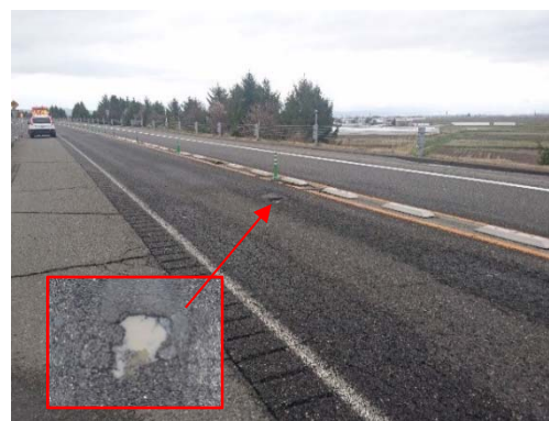
舗装路面の状況（会津坂下IC～会津若松IC間）
