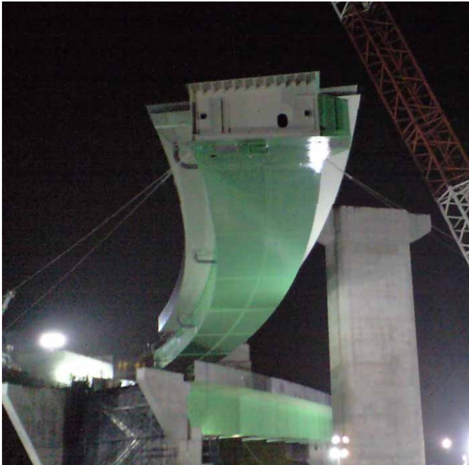
平成21年6月に富谷JCT(仮称)で架設した橋梁の事例
