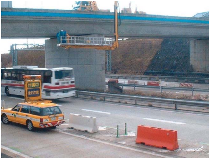
橋梁点検車による点検
