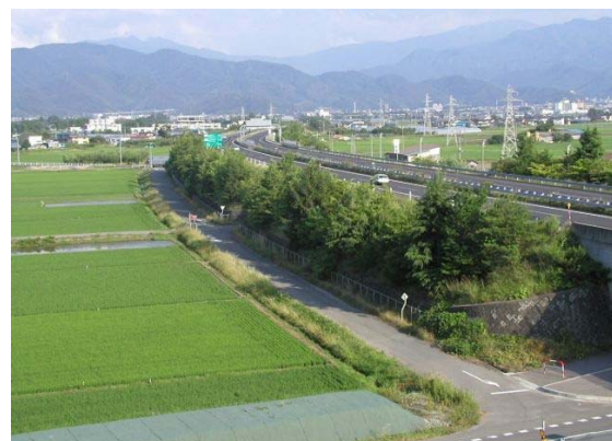
高速道路法面の樹林化
