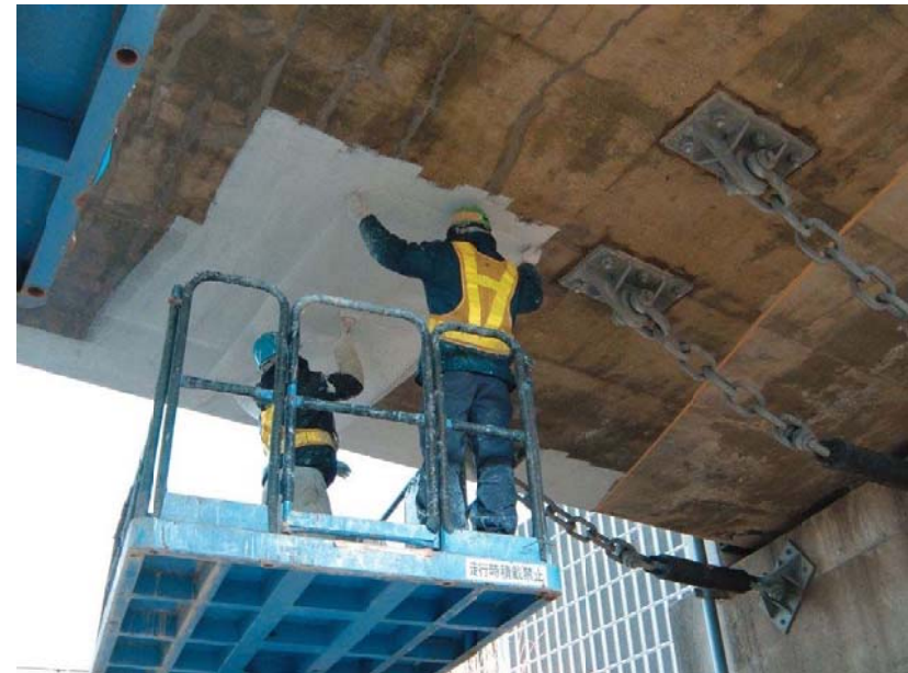
修繕工事の状況(床版下面の繊維シート貼付)
