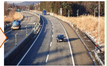
4車線化後(坂田新田橋)
