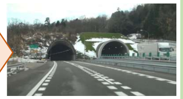
4車線化後(観音平トンネル)
