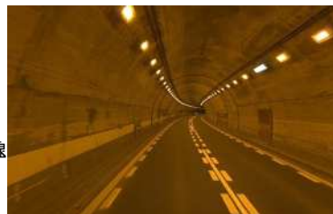
【張碓トンネル】
