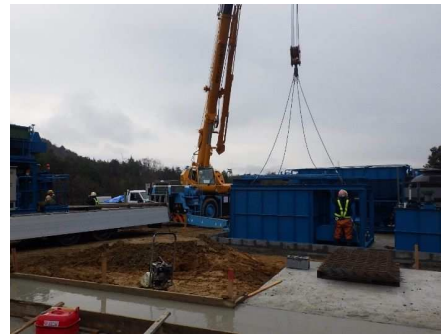
汚濁水処理工（設置状況）
