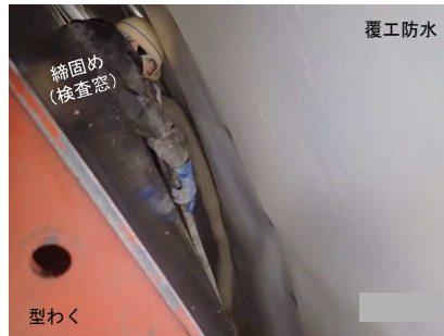
覆工コンクリート (打設)
