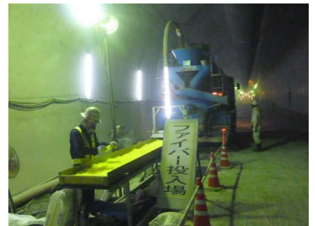
繊維現地混合 (覆工コンクリート)
