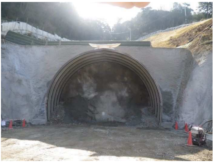
坑口切付施工完了
