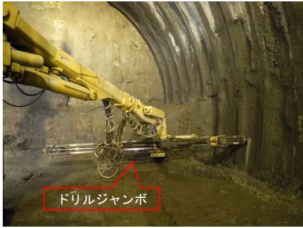
削孔 (ロックボルト)
