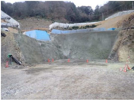
吹付コンクリート施工
