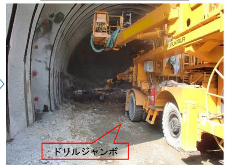
削孔 (ロックボルト)
