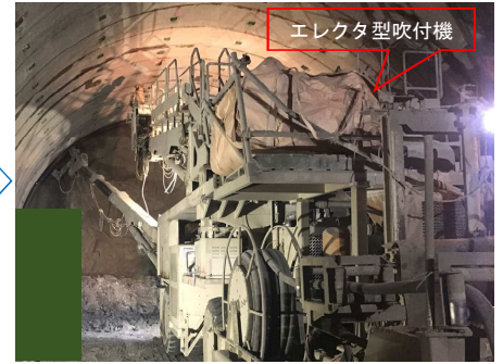
鋼アーチ支保工
