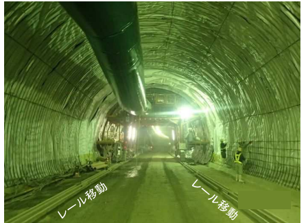
型枠移動 (養生完了後)
