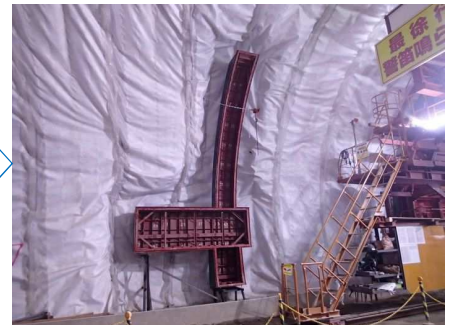
型わく据付 (箱抜き型わく)
