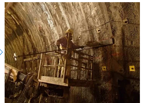
補強ロックボルト
