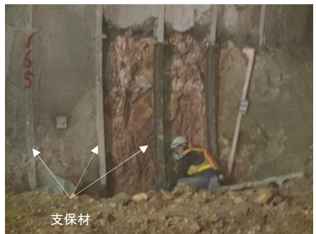
鋼アーチ支保工
