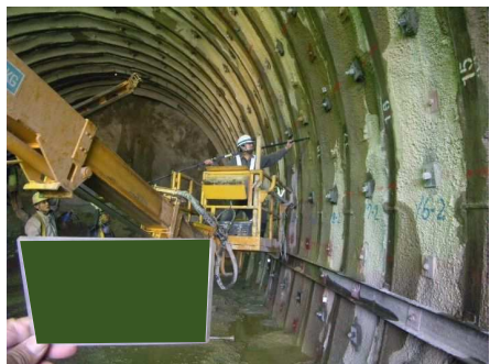
計測工B（地中変位測定）
