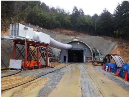
換気設備工（設置完了）
