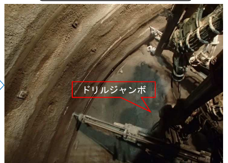
打設 (ロックボルト)
