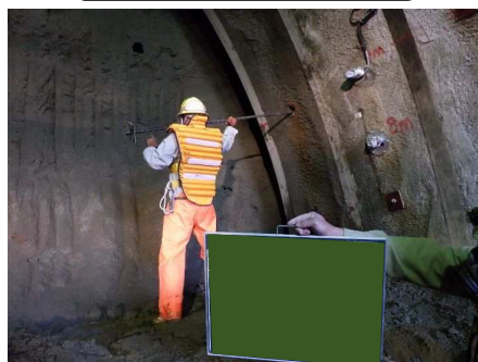
打設（ロックボルト）
