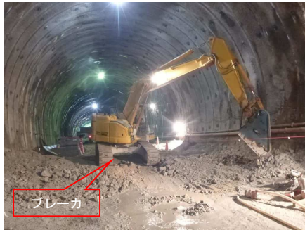
インバート掘削
