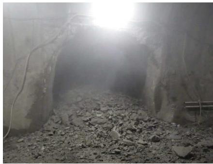
ずり処理 ( ずり 積 込 み )
