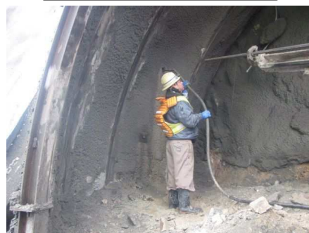
モルタル充填 (ロックボルト)
