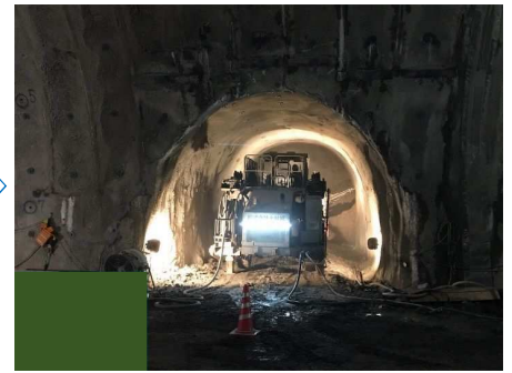
削孔 ( ロックボルト )
