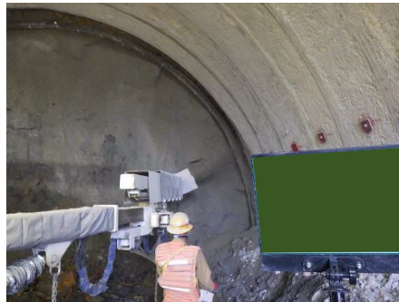
吹付コンクリート
