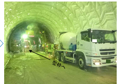
覆工コンクリート (ミキサー車)
