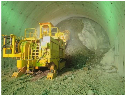
上半掘削 (トンネル掘進機)
