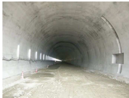
覆工コンクリート打設完了
