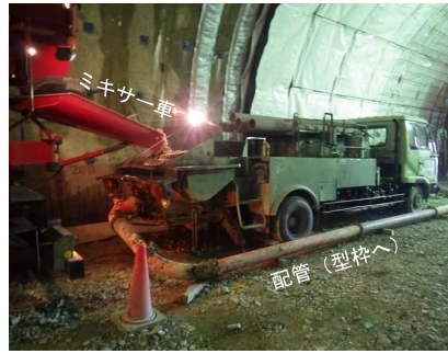
覆工コンクリート (打設)
