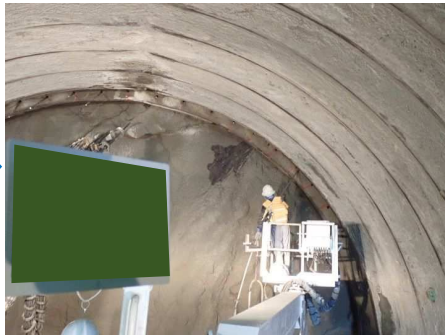
モルタル充填（フォアポーリング）
