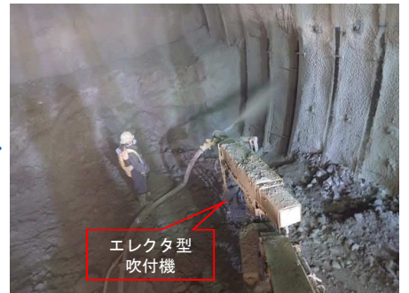
吹付コンクリート
