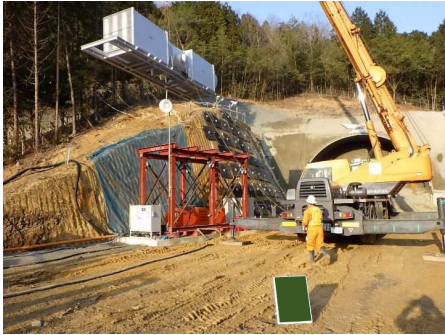
換気設備工（設置状況）
