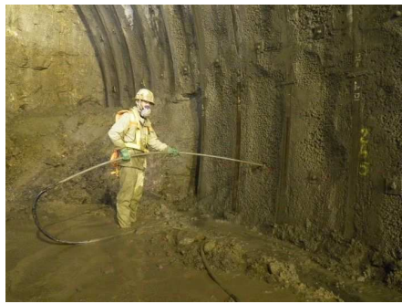
モルタル充填 (ロックボルト)
