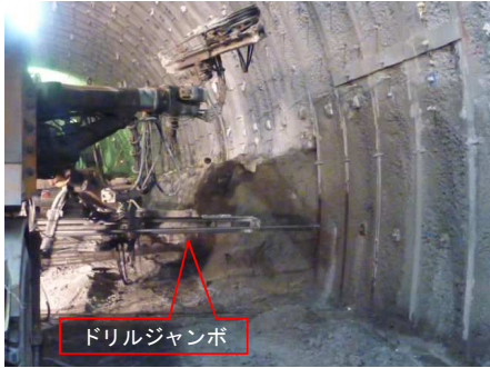
ロックボルト打設
