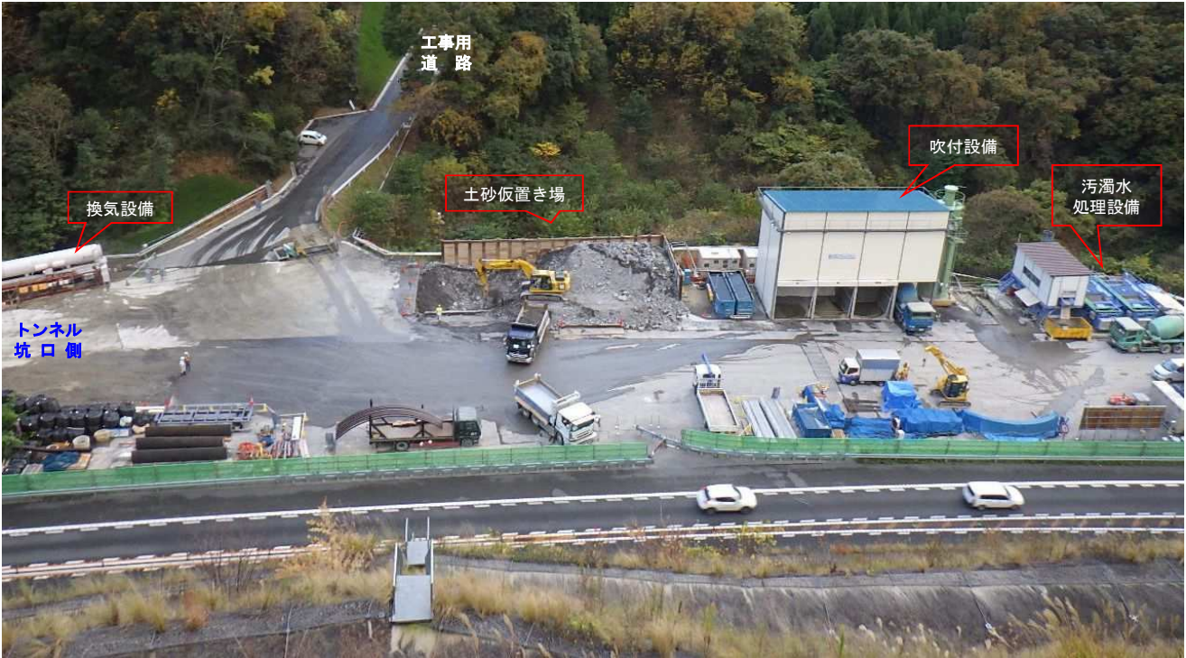
施工ヤード全景
