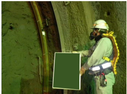
計測工B（覆工の応力測定）
