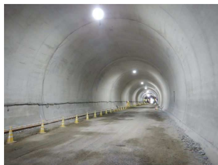
トンネル工完成
