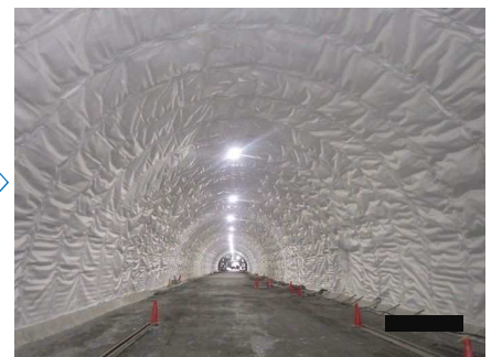
覆工防水工完了
