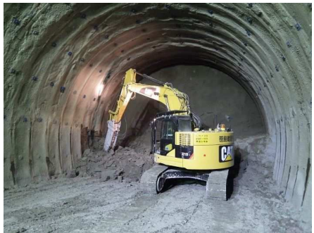
下半掘削（ブレーカ）
