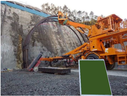
鋼アーチ支保工設置
