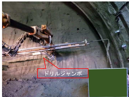
削孔（ロックボルト）
