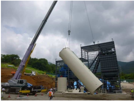
換気設備工（設置状況）
