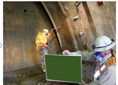
モルタル充填（ロックボルト）
