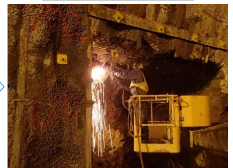
ロックボルト工（撤去）
