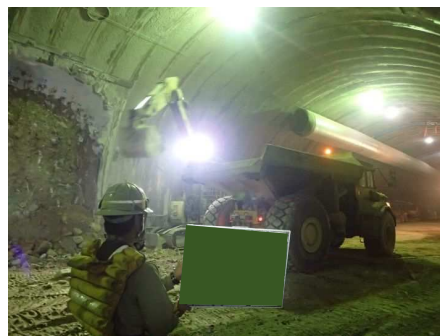
ずり処理 ( ずり 積 込 み )
