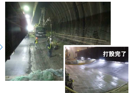
インバートコンクリート打設
