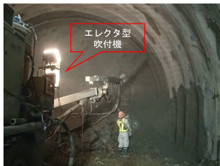
吹付コンクリート
