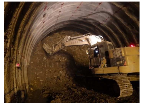
上半掘削 (油圧切削機)
