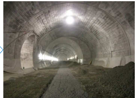
路盤排水工設置完了
