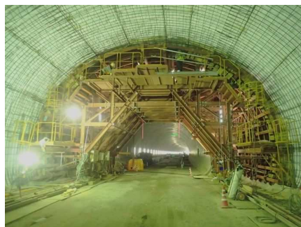
型わく据付完了
