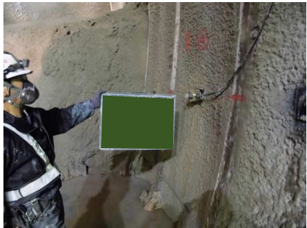
計測工B（ロックボルト軸力試験）
