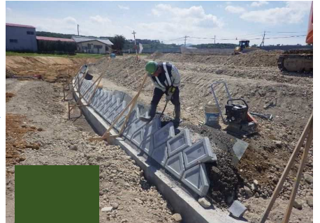
胴込め (コンクリート)
