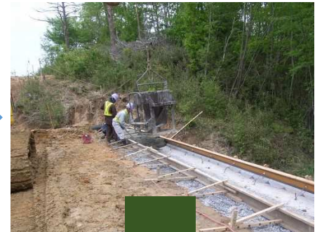
天端コンクリート打設
