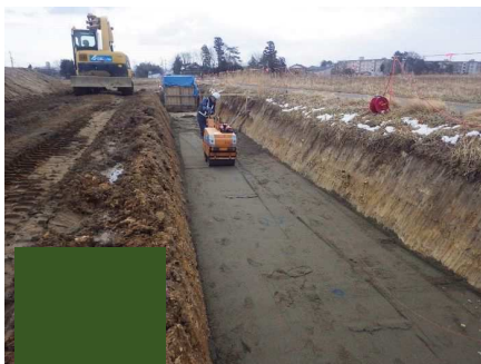
基礎材敷均し・締固め
