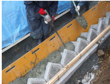
胴込め（※コンクリート打設の場合）
