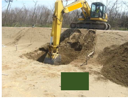
掘削・整正（床付）
