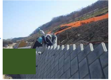
コンクリートブロック積み②
