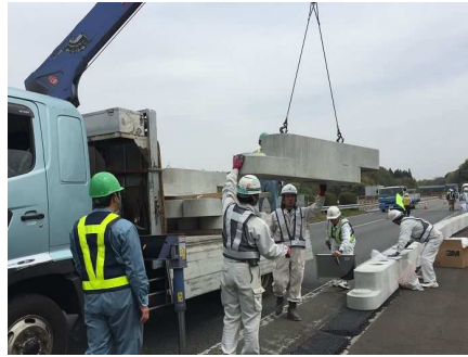
連続基礎ブロック設置
