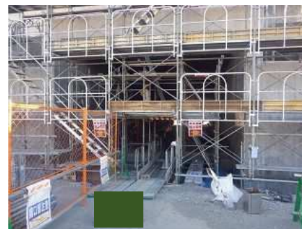
支保・型枠・足場撤去
