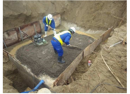
基礎材敷均し・締固め
