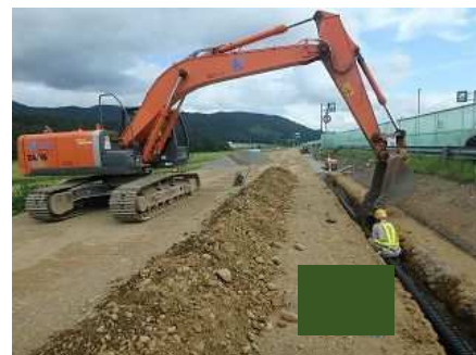
フィルター材設置
