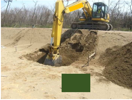
掘削・整正（床付）
