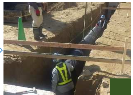
用排水管設置
