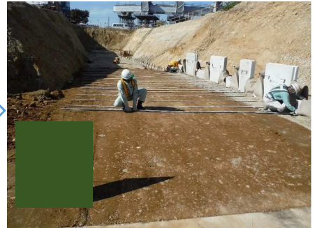
補強材設置
