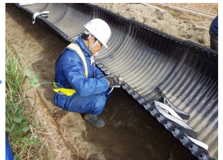
パイプ組立 (ボトムセクション)
