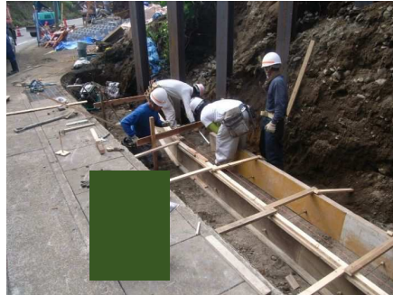
型枠製作・組立て
