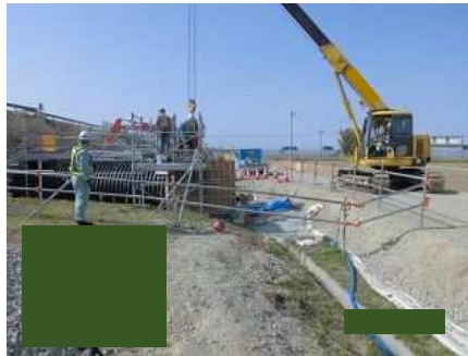
コンクリート打設①
