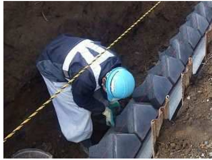
コンクリートブロック積み①
