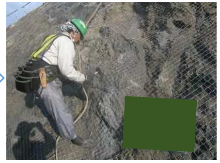
アンカーピン設置
