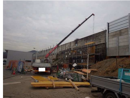
型枠製作・組立て
