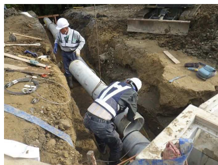
用排水管設置
