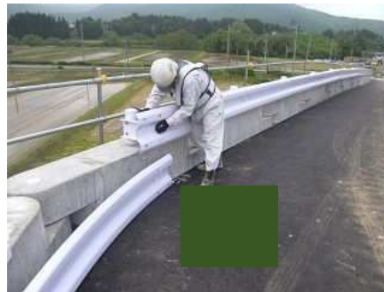
レール等設置
