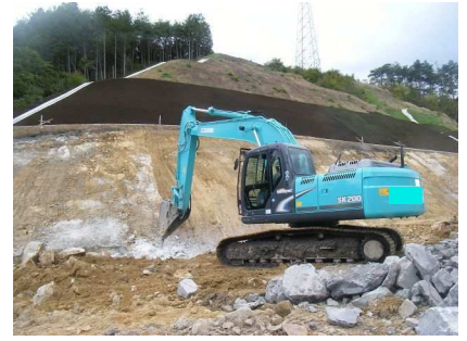
切土のり面仕上げ(硬岩)
