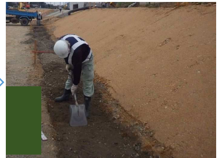
基礎材敷均し・締固め
