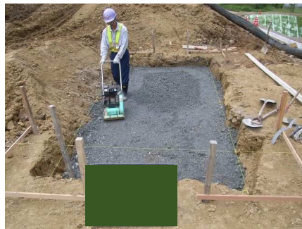
基礎材敷均し・締固め
