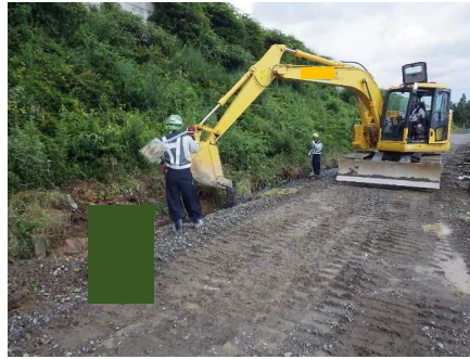
掘削・整正（床付）
