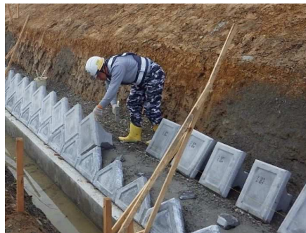
コンクリートブロック積み①
