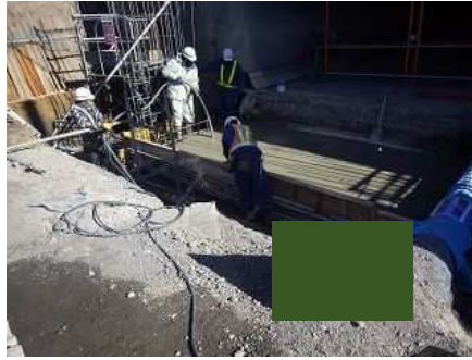
↓ 底版コンクリート打設
