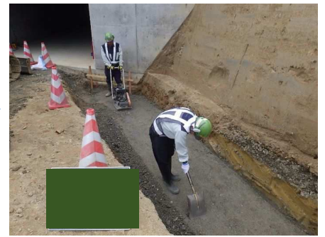
基礎材敷均し・締固め
