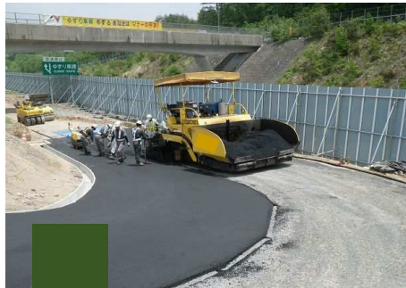
簡易舗装工 (敷均し)
