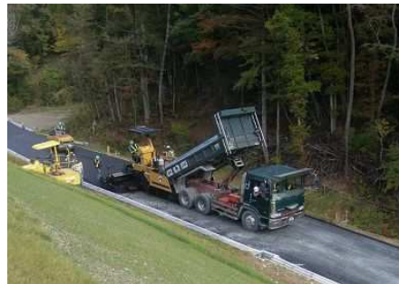
簡易舗装工（敷均し）
