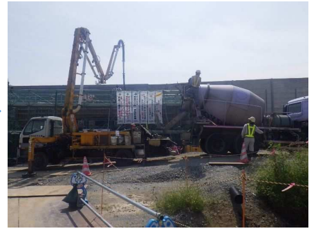
コンクリート打設・養生
