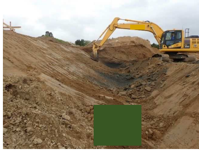
切土のり面仕上げ (土砂)
