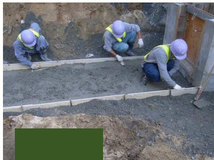
均しコンクリート打設
