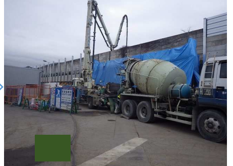
コンクリート打設・養生
