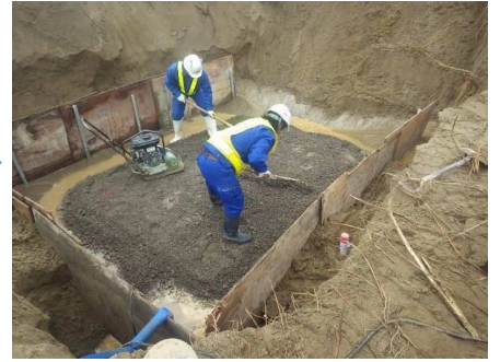
基礎材敷均し・締固め
