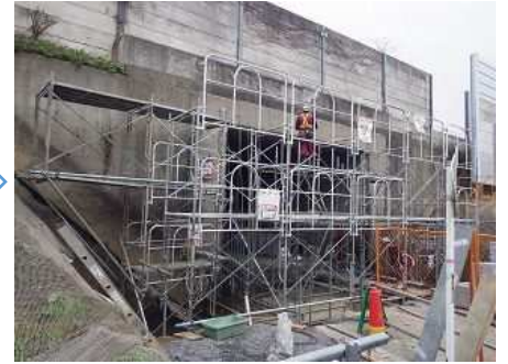
足場・支保設置
