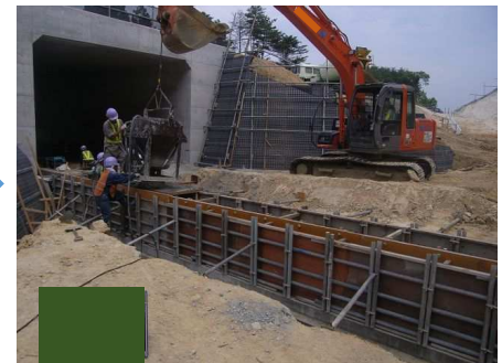
コンクリート打設
