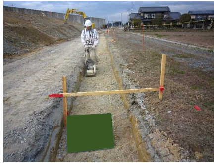
掘削・整正 (床付)
