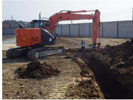
掘削・整正 (床付)
