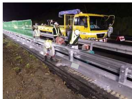
固定用アンカーピン打込み
