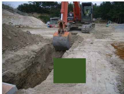
掘削・整正 (床付)
