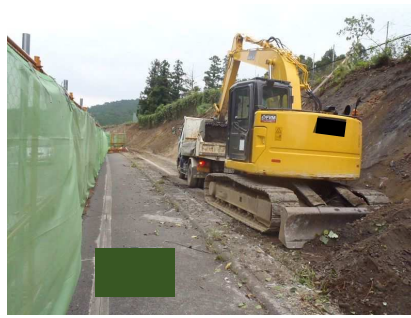
掘削・積込み
