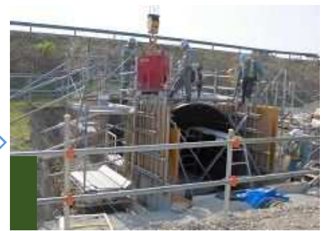
コンクリート打設②
