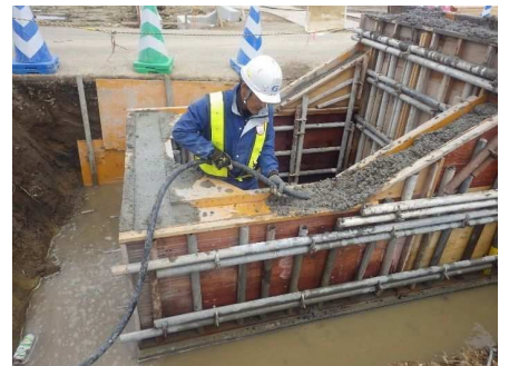
コンクリート打設
