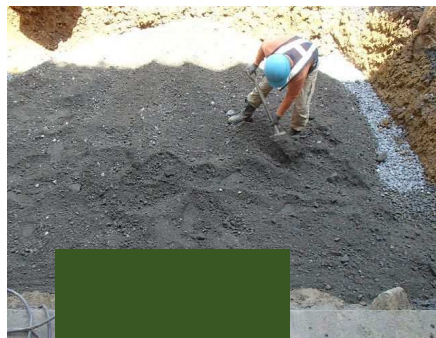
基礎材敷均し・締固め
