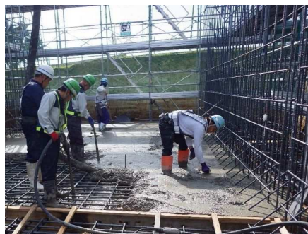
底版コンクリート打設
