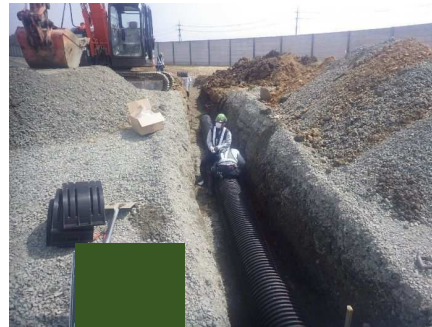
用排水管設置
