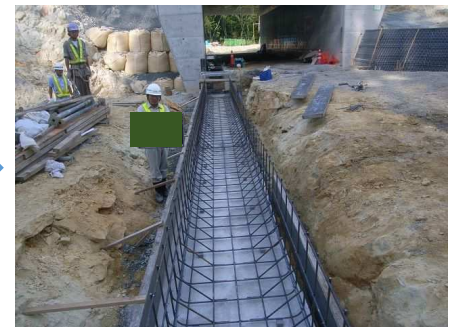
鉄筋加工・組立て
