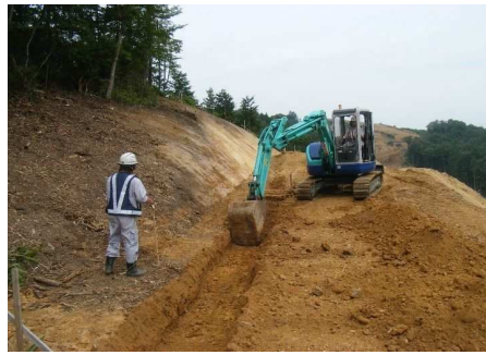
掘削・整正 (床付)
