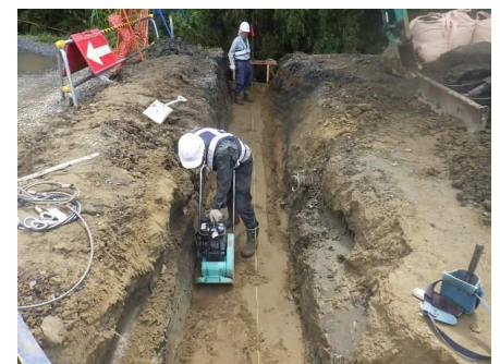
基礎材敷均し・締固め
