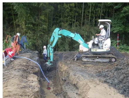
掘削・整正 (床付)
