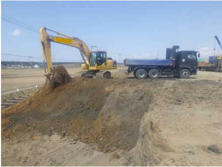
掘削・積み込み
