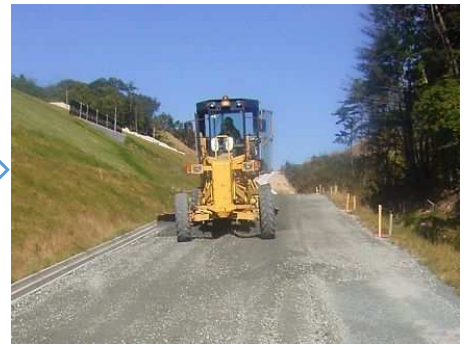
簡易舗装路盤工
