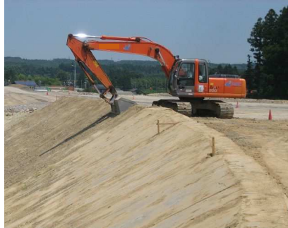
盛土のり面仕上げ(削取り)
