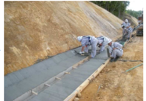
コンクリート打設
