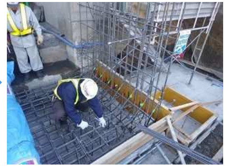
底版鉄筋加工・組立て
