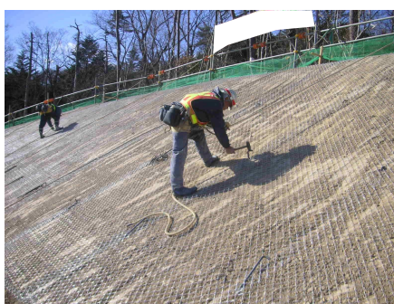
アンカーピン設置
