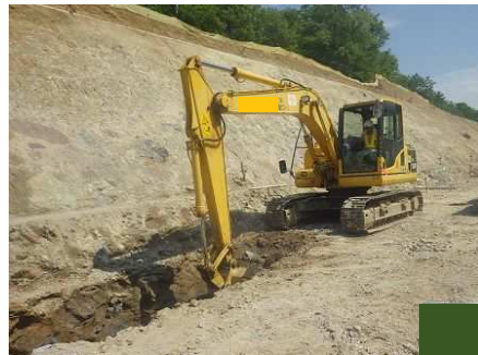
掘削・整正（床付）
