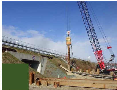
打込み(H型鋼)
