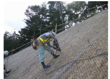
アンカーピン設置
