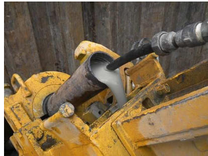
グラウト注入
