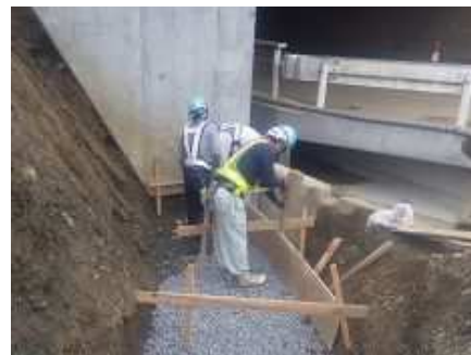
型枠製作・組立て
