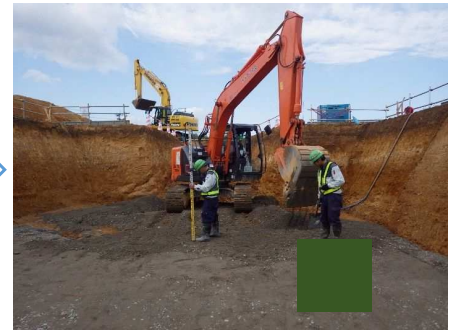
基礎材敷均し
