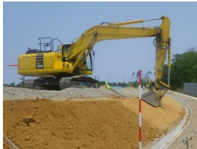
盛土のり面仕上げ (削取り)
