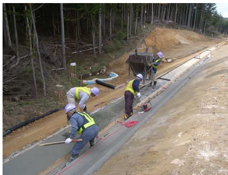
コンクリート打設
