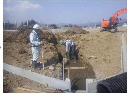
基礎材敷均し・締固め
