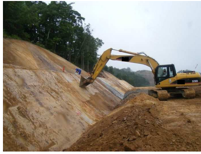
切土のり面仕上げ(土砂)
