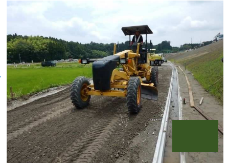
簡易舗装路盤工
