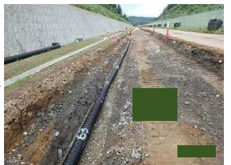
地下排水管設置
