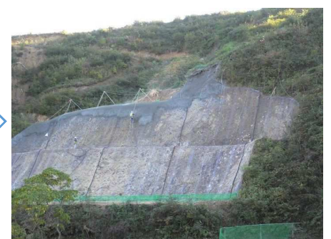
モルタル吹付
