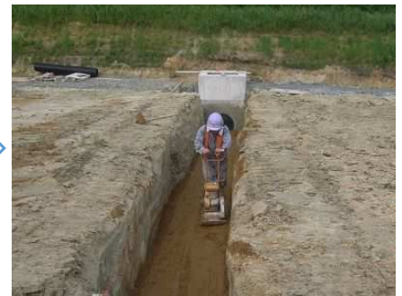
基礎材敷均し・締固め
