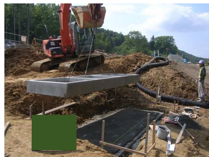
油水分離ます設置
