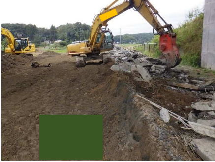
取壊し（圧碎機）
