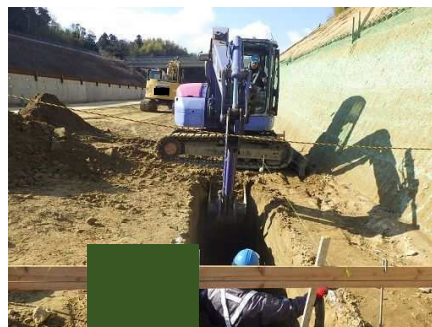
掘削・整正 (床付)
