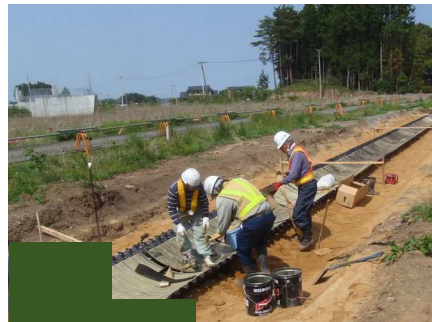
パイプ組立（ボトムセクション）
