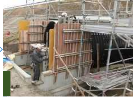
型枠組立②
