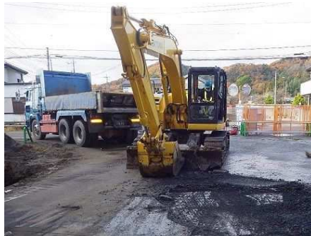
舗装版取壊し
