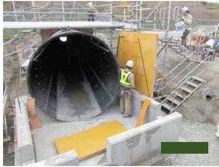
型枠組立①
