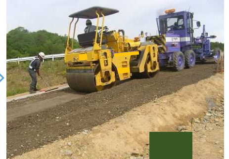
簡易舗装路盤工 (転圧)
