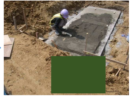
敷モルタル設置
