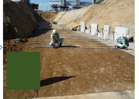
補強材設置
