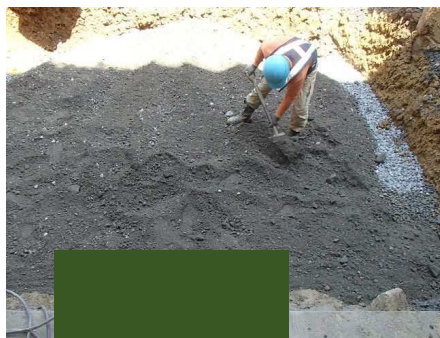
基礎材敷均し・締固め
