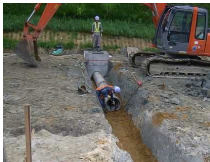
用排水管設置
