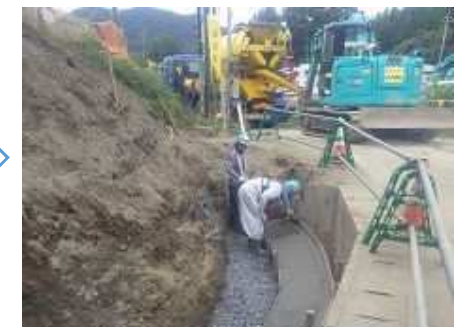
コンクリート打設
