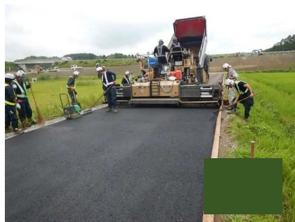
簡易舗装工（敷均し）
