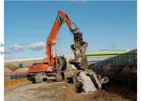
取壊し (圧碎機)
