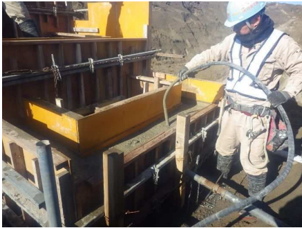
コンクリート打設
