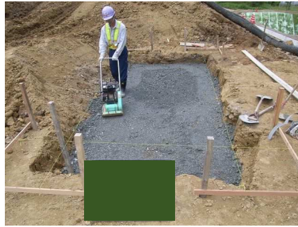
基礎材敷均し・締固め
