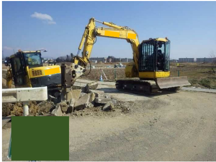
取壊し（大型ブレーカ）
