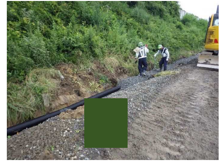
地下排水管設置
