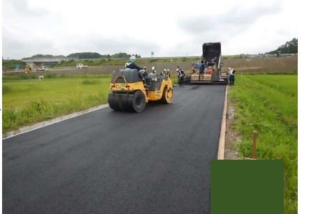
簡易舗装工（締固め）
