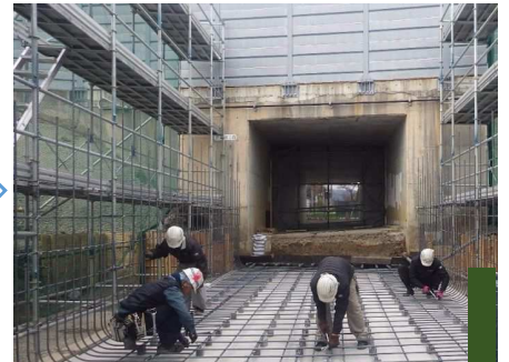
底版鉄筋加工・組立て
