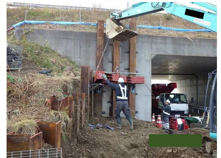
鋼製山留材設置
