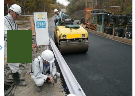
簡易舗装工 (締め)
