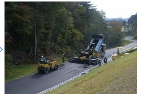
簡易舗装工（締固め）
