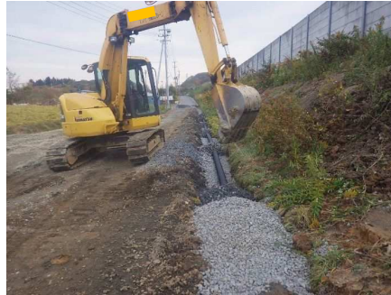
フィルター材設置
