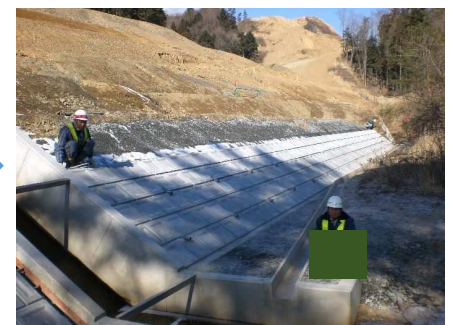
コンクリートブロック張り
