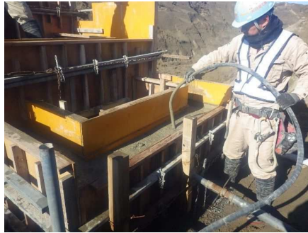
コンクリート打設
