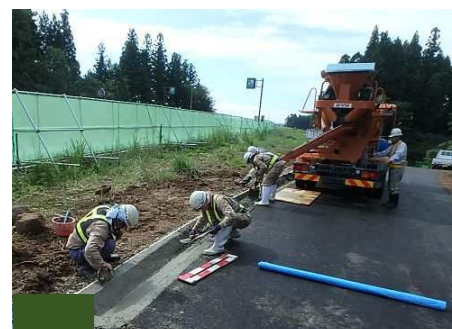
コンクリート打設
