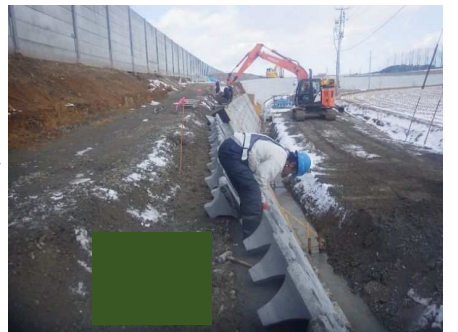
コンクリートブロック積み②
