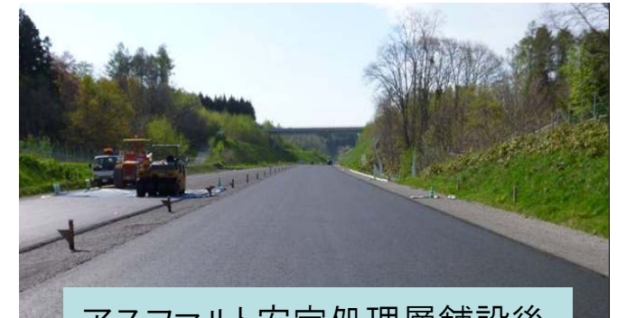
アスファルト安定処理層舗設後
