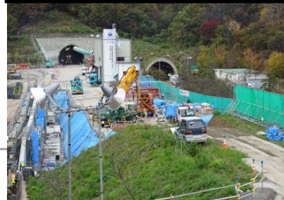
④ 天神堂トンネル(南坑口)施工状況
