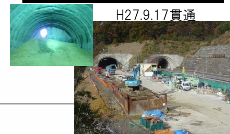
⑤ 金谷山トンネル施工状況
