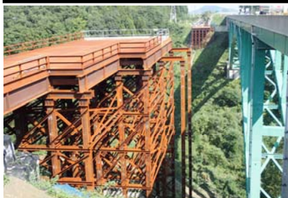
② 太田切川橋工事で道路施工状況
