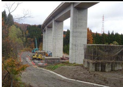
① れいめい橋下部工施工状況
