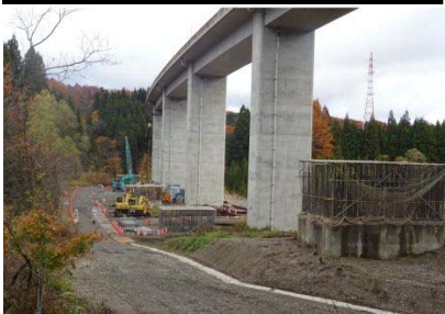
① れいめい橋下部工施工状況
