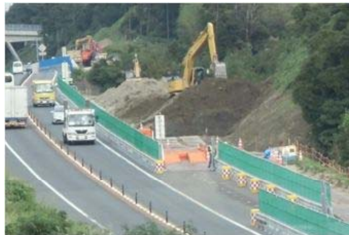
本線工事用進入路における安全対策
